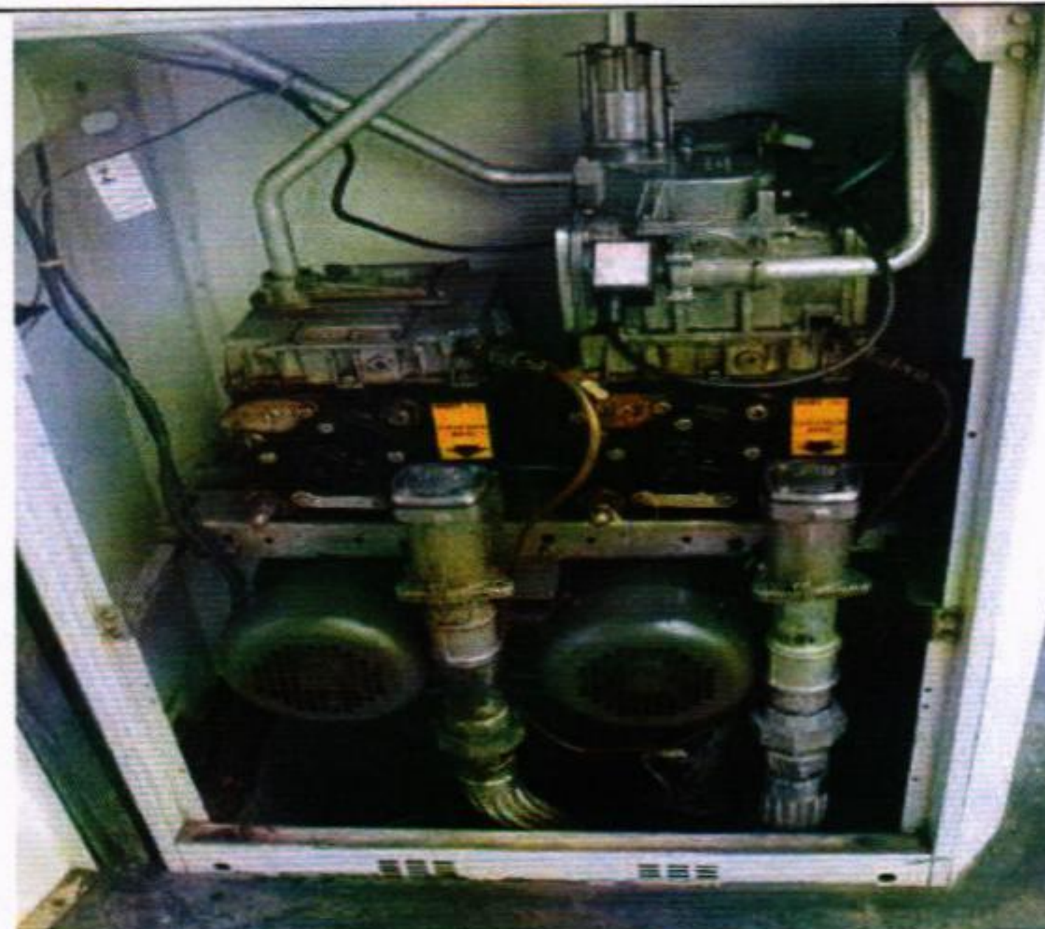
Bombas de abastecimento com SUMP e chekvalve
