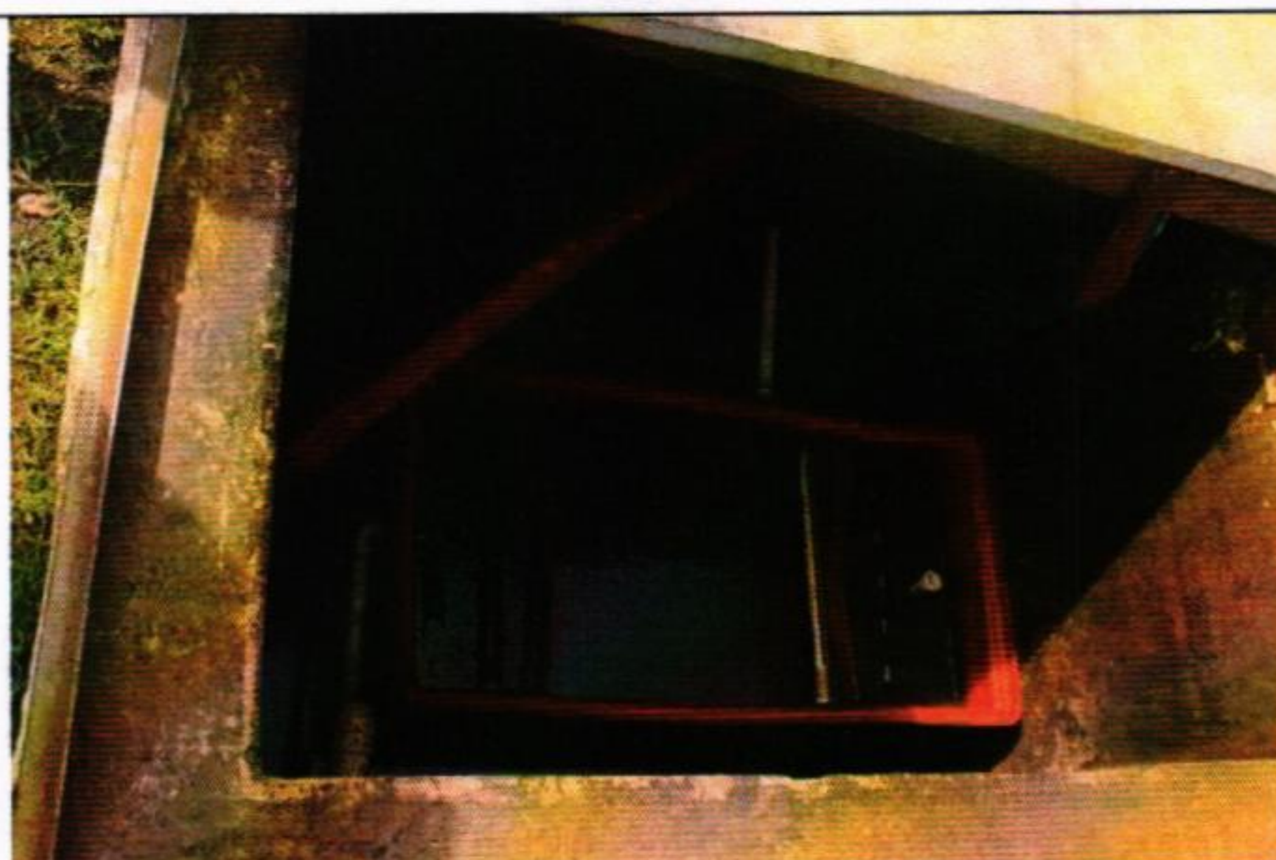
Caixa separadora de água aonde o efluente é bombeado para rede coletora da COPASA
