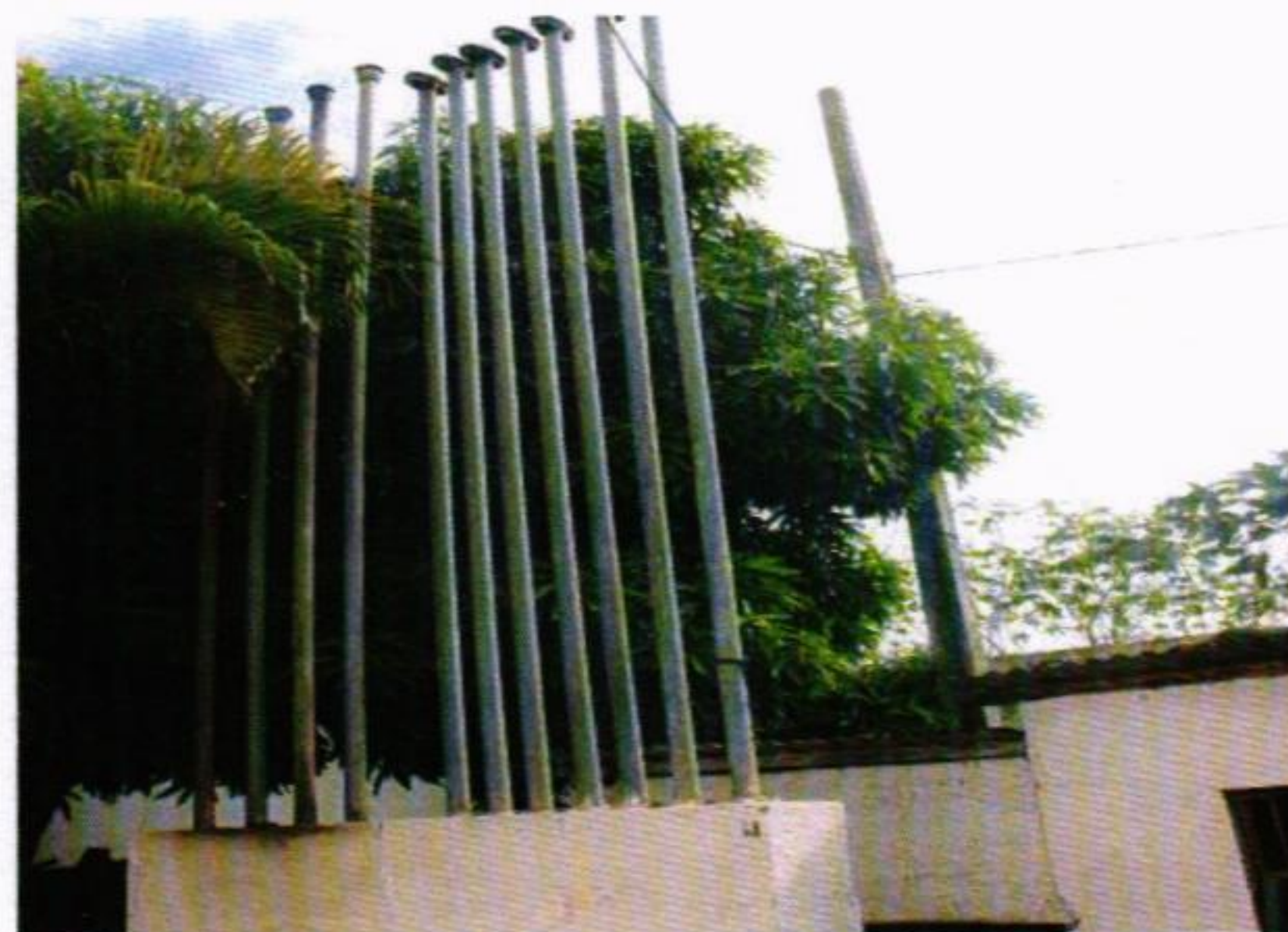
Suspiros dos tanques
