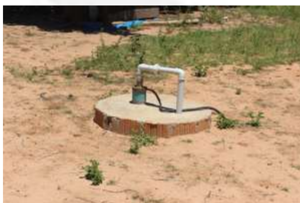
Foto 03. Poço tubular sem horrífero nem hidrômetro.
