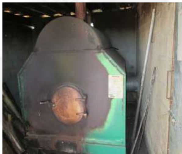
Figura 4: fornalha que aquece os galpões
