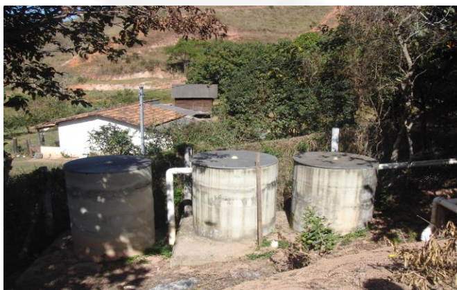
Foto 05. Sistema de Tratamento de efluentes líquidos
