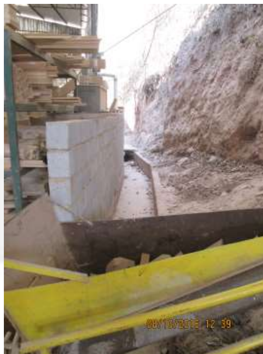
Imagens 20 e 21 (atuais): Mureta construída para impedimento da descida da água pluvial, bem como a canalização da água direcionada, por meio de um cano, para fora da área industrial, unindo-se a canaleta principal descendo na entrada da fábrica
