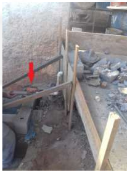
Imagens 22 e 23 (ano/2015) – Fechamento da bacia de contenção e detalhe da montagem do sistema de drenagem.
