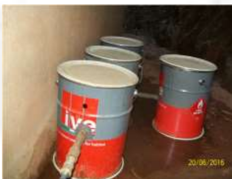
Imagem 38: Sistema de separação de água e óleo do compressor da purga.
