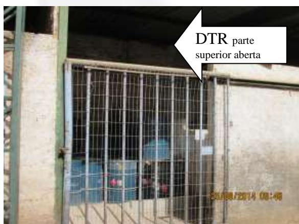
Imagens 10 e 11 ( ano/2014 ) – DTR – Depósito Temporário de Resíduo e, ao lado, Depósito de Insumos. A parte superior dos depósitos abertos, favorável a entrada de água da chuva e possível contaminação com os resíduos.
