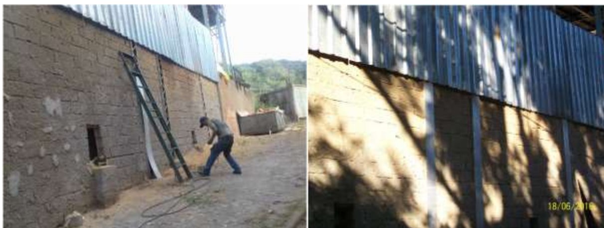
Imagens 30 e 31: Trabalho de fechamento das aberturas no box dos silos de ferragem evitando a dispersão da poeira
