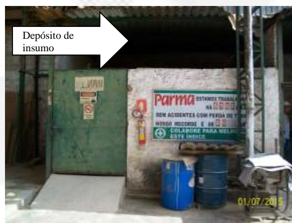
Imagens 10 e 11 ( ano/2014 ) – DTR – Depósito Temporário de Resíduo e, ao lado, Depósito de Insumos. A parte superior dos depósitos abertos, favorável a entrada de água da chuva e possível contaminação com os resíduos.
