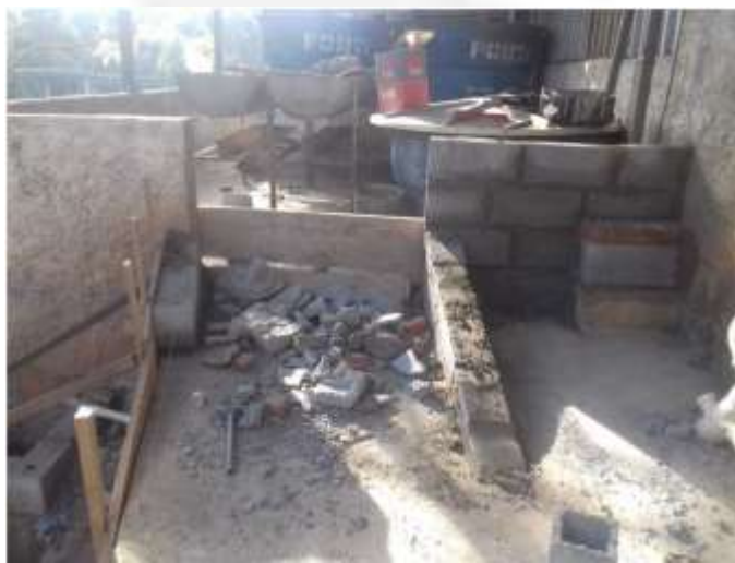
Imagens 22 e 23 (ano/2015) – Fechamento da bacia de contenção e detalhe da montagem do sistema de drenagem.
