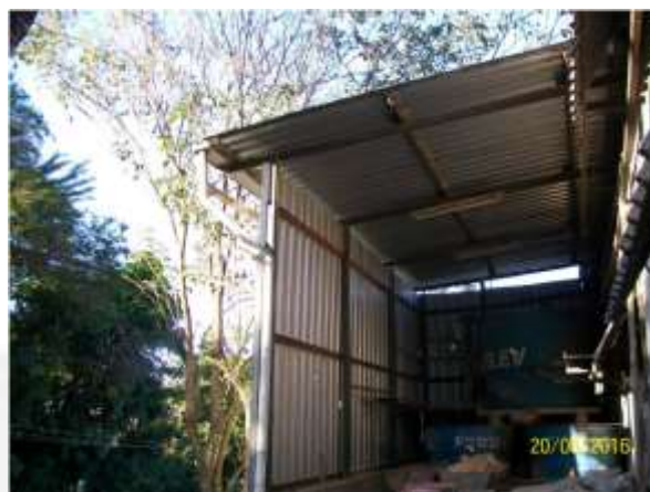
Imagens 24 e 25 (ano/2015) – Detalhe da rampa de acesso a ETI e o fechamento das laterais evitando a entrada de água de chuva
