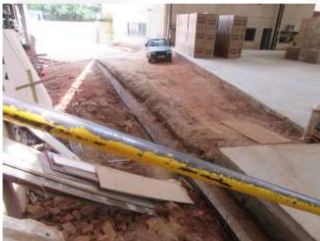
Imagem 18 (ano/ 2015): Implantação da canaleta e do pátio
