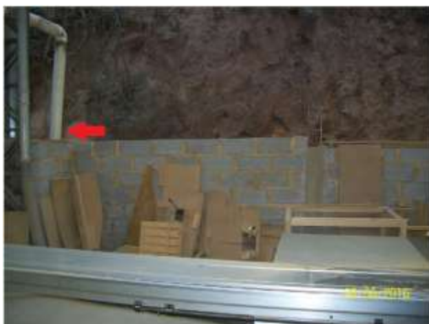
Imagens 20 e 21 (atuais): Mureta construída para impedimento da descida da água pluvial, bem como a canalização da água direcionada, por meio de um cano, para fora da área industrial, unindo-se a canaleta principal descendo na entrada da fábrica
