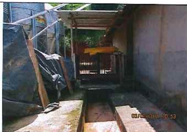
Foto 5: silos da fábrica de ração com dutos de conexão para as baias e canaletas de água pluvial
