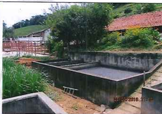
Foto 8: tanque de equalização do efluente bruto, suinocultura, curral e área de pasto na parte inclinada
