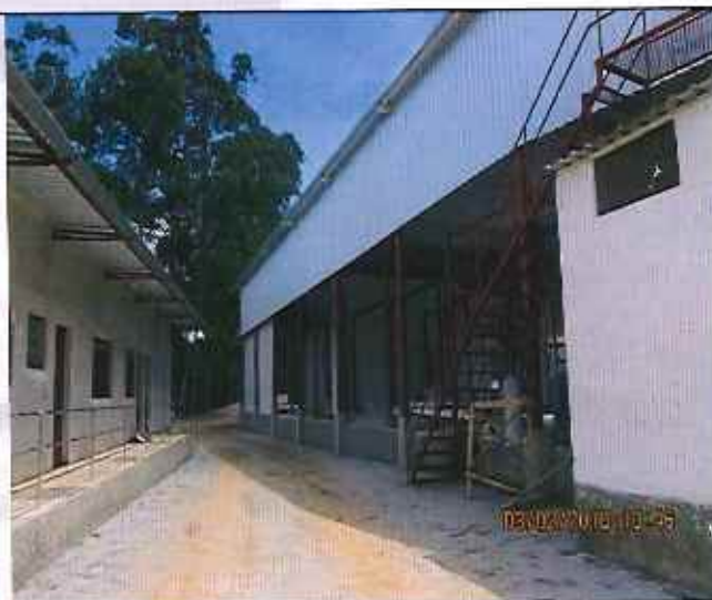
Foto 2: prédio a direita onde se instalará o abatedouro bovino com o escritório e refeitório a esquerda
