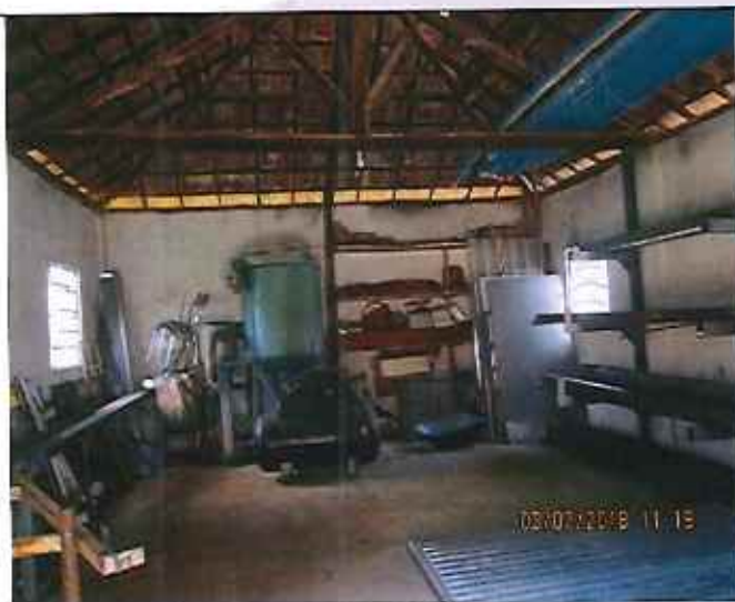
Foto 1: serralheria do empreendimento
