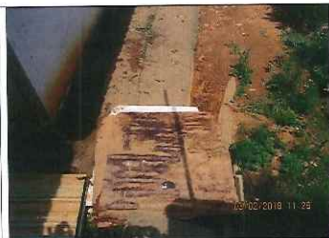
Foto 11: fossa séptica do esgoto doméstico; está interligada a planta de tratamento de efluente
