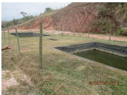
Figura 7: Lagoas para tratamento de Percolados
