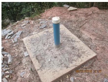
Figura 11: Poço para captação de água subterrânea
