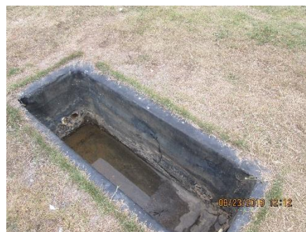
Figura 8 : Lançamento em caixa distribuidora de vazão
