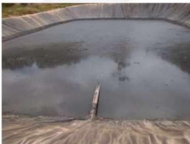
Fig. 1 – primeira lagoa impermeabilizada
