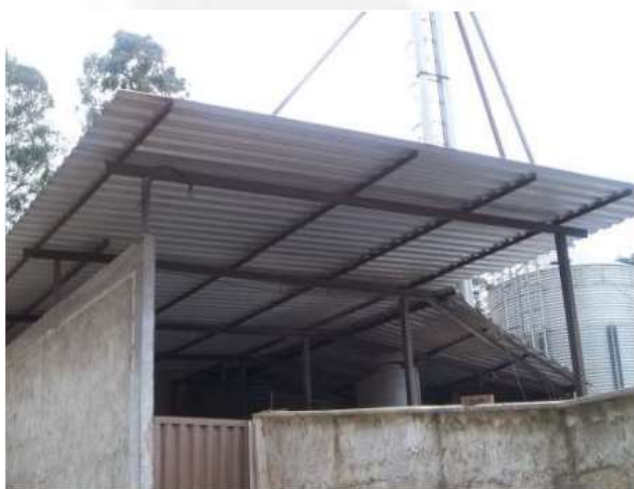
Fig 3 : Troca do telhado facilitando o escoamento de águas pluviais.
