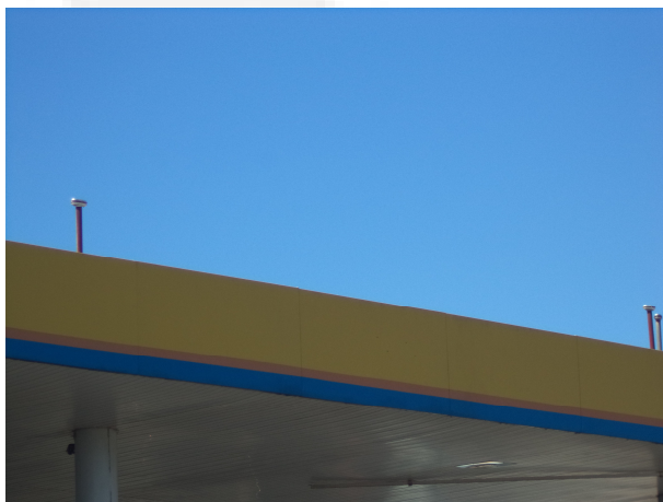
Foto 03. Respiros dos tanques
