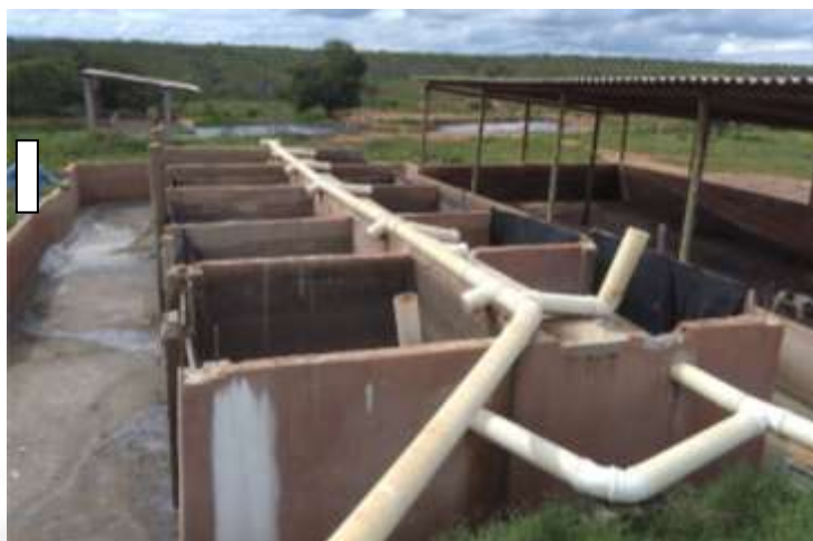
Figura 9. Separador de sólidos como leito de secagem à direita. Fonte: Acervo SUPRAM-NM, 2017.
