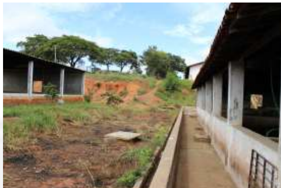
Figura 2. Sistema de drenagem pluvial.
