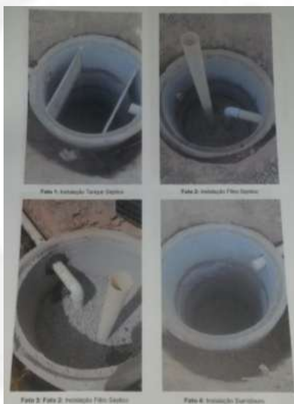
Figura 13. Finalização da instalação do sistema fossa séptica. Fonte: Informações Complementares, 2017.
