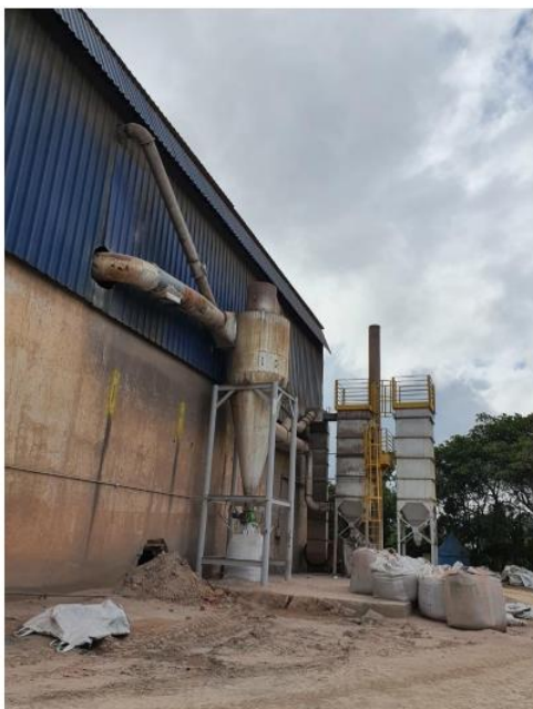
Foto 03. Sistema de despoeiramento do forno
