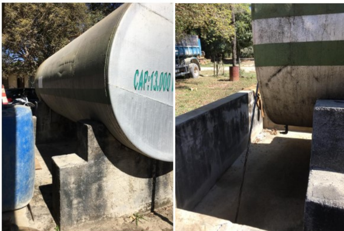
Figura 2.3.2. Tanque aéreo para o abastecimento de combustíveis com capacidade para 13.000 litros. Local possui bacia de contenção.
