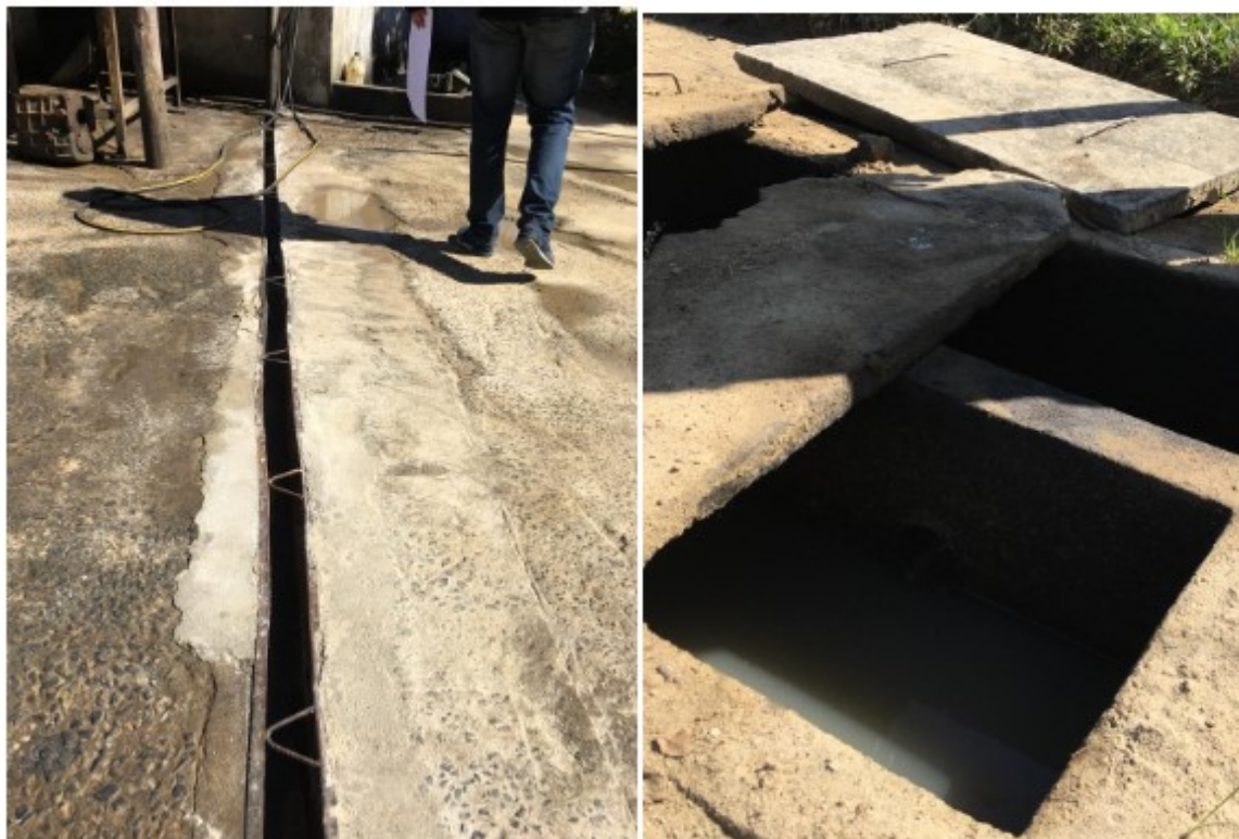
Figura 2.3.3. Canaleta de limite direcionada para sistema separador água óleo atendendo o ponto de abastecimento de combustíveis.
