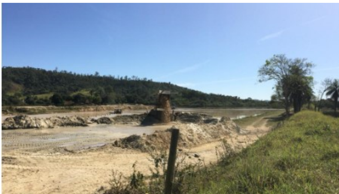
Figura 2.3.1. Dragagem em operação. A água e a areia (polpa) é succionada e bombeadas para a área de escoamento de depósito.
