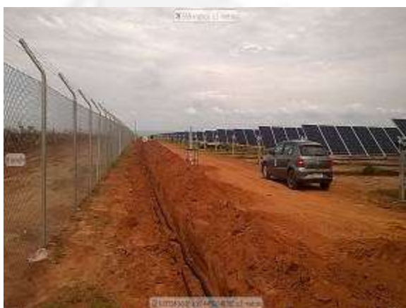
Foto 15. Cabos para monitoramento por câmeras de vídeo.
