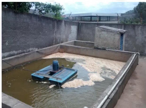
Foto 04. Tanque de Aeração da ETE
