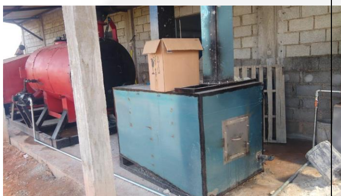
Foto 9: Lavador de gases da caldeira
