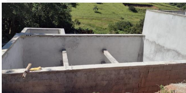
Foto 11: Tanque de decantação
