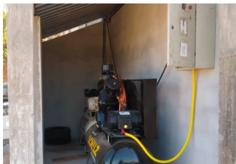
Foto 7: Compressor de ar comprimido
