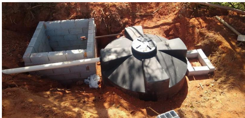
Foto 15: Biodigestor
