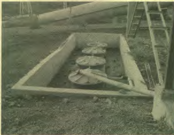
Foto 01. Caixa Separadora de água e óleo da oficina
