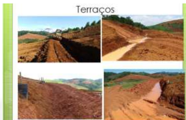
Figura 12: Mostra um trator construindo um terraço, terraços construídos e retendo água pluvial. Fonte: Votorantim - CBA
