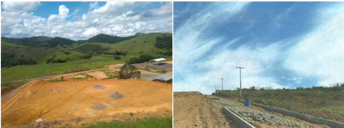
Figura 5 - À direita, vista para a entrada do empreendimento e segundo platô destinado ao recebimento futuro de produtos acabados e despacho. À esquerda, estrada de acesso interno em obras. Fonte: SUPRAM ZM e RCA.
