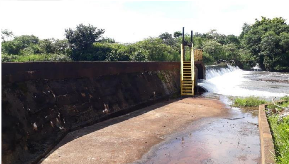
Figura 09: Vertedouro de Crista Livre e comporta de fundo. Fonte: Ofício IC - documento SEI nº 42609334 (2022).
