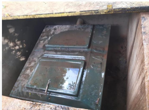
Foto 04: Caixa Separadora Água e Óleo, instalada nas proximidades do Transformador Elevador. Fonte: Ofício IC - documento SEI nº 42609334 (2022).
