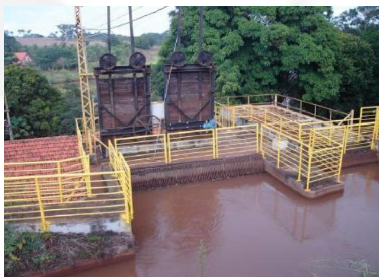
Figura 06: Vista da comporta e grades da tomada d'água. Fonte: Ofício IC - documento SEI nº 42609334 (2022).
