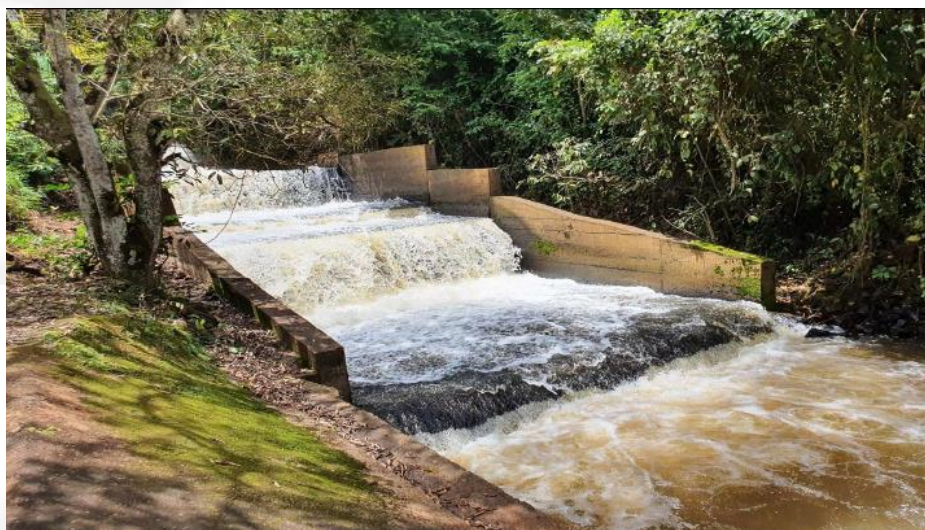
Figura 05: Vista de jusante da estrutura do descarregador de fundo do canal de adução. Fonte: Ofício IC - documento SEI nº 42609334 (2022).
