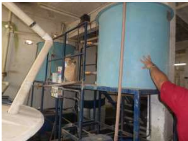
Foto 01. ETEi (Taques de tratamento do efluente ácido e alcalino)
