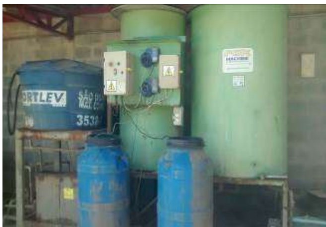
Fig. 5 – ETE sistema de lavador de veículos com recirculação do efluente.
