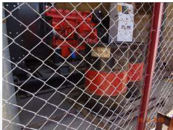
Fig. 6 – Gerador em local fechado e com sistema de contenção para possíveis vazamentos..
