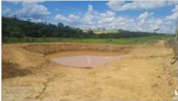
Foto 02. Sistema de drenagem pluvial (cacimbas).
