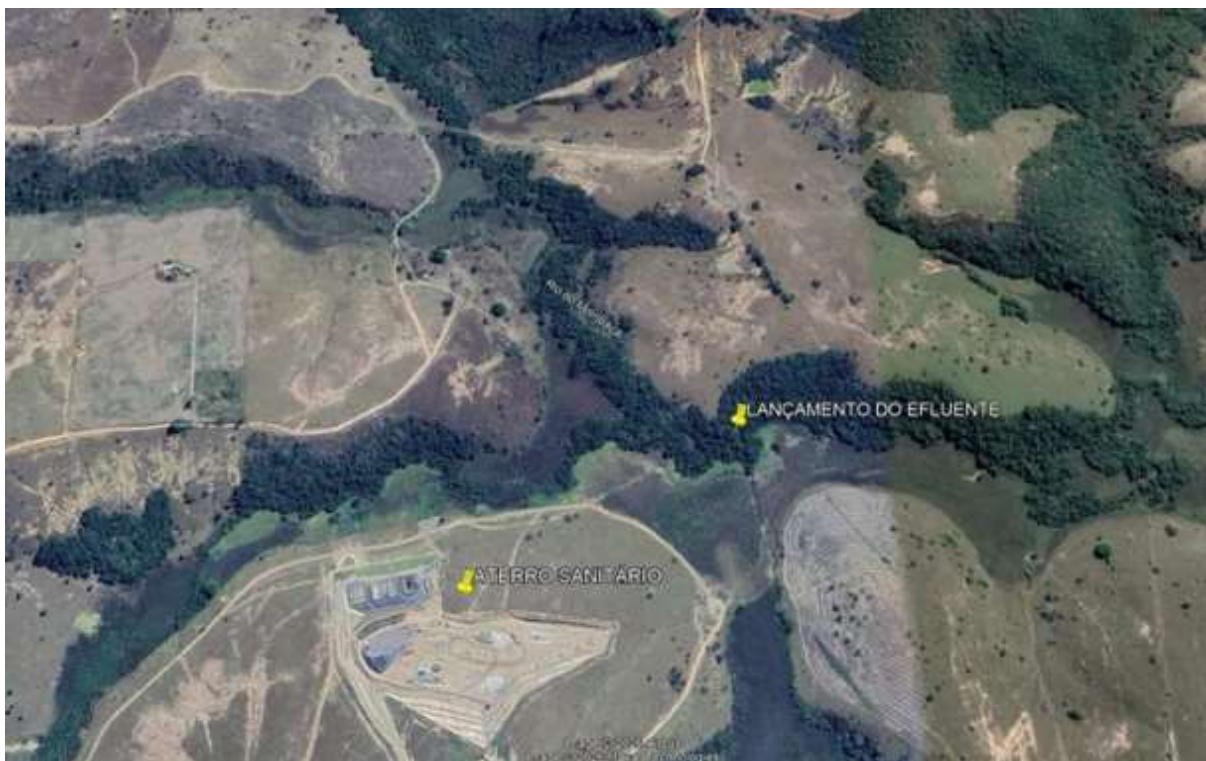
Figura 15: Ponto de lançamento do chorume tratado. Fonte: Informações Complementares.
