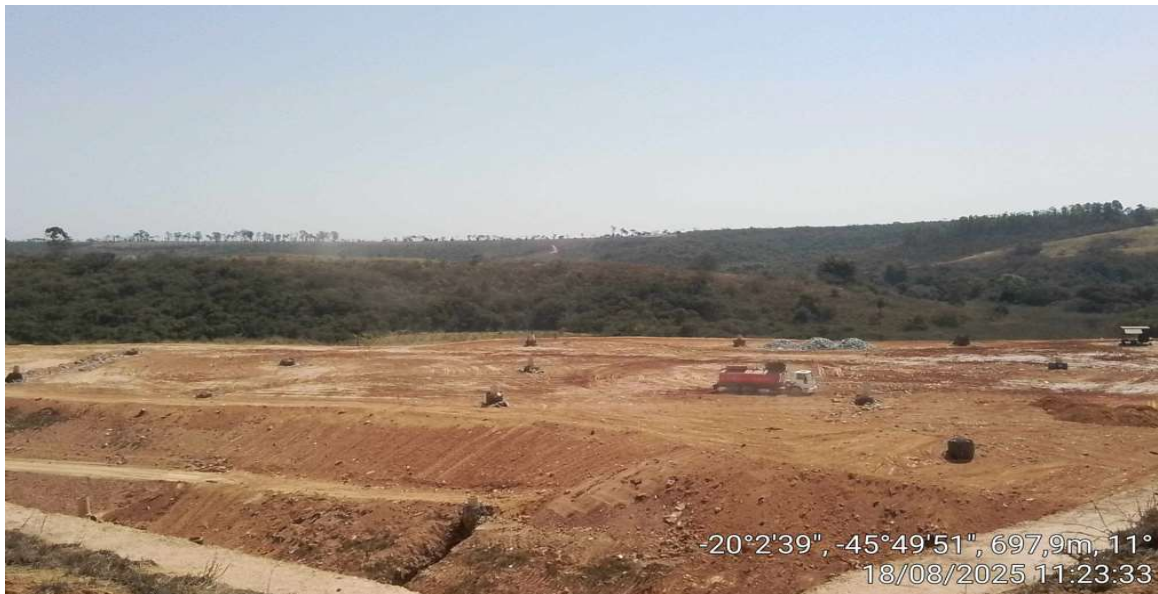
Foto 01. Visão Geral da Área de Aterragem.
