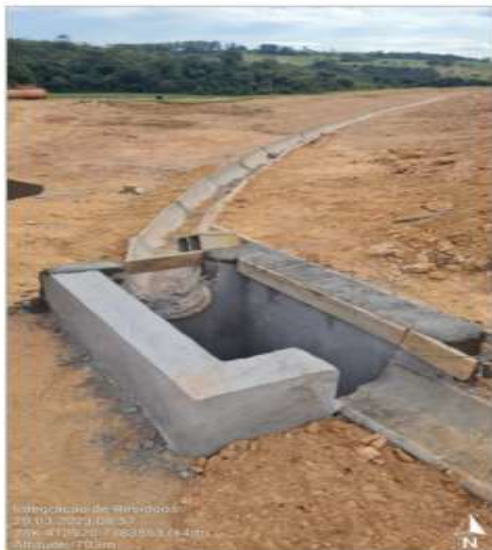
Foto 02. Sistema de drenagem pluvial do maciço.
