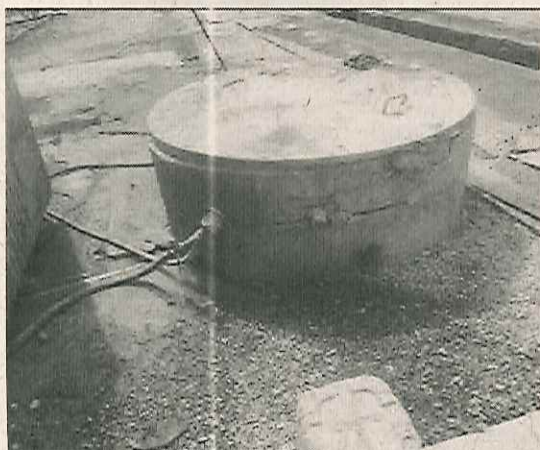
Foto 09. Cisterna utilizada na área de lavagem de veículos.
