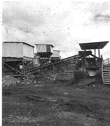
Foto 08. Planta de beneficiamento
