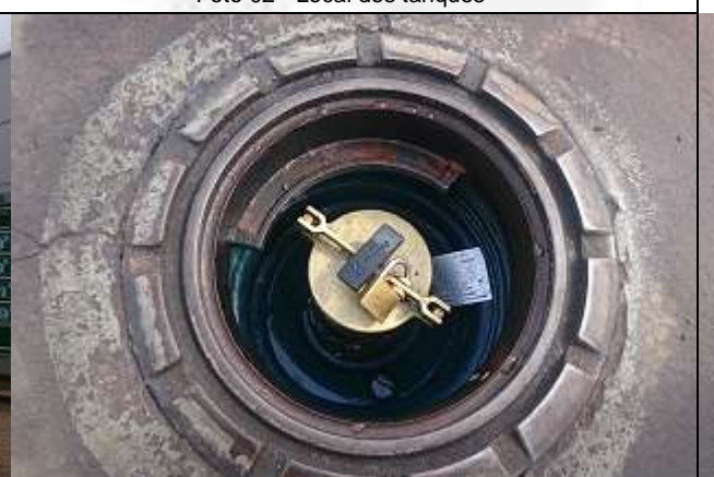
Foto 04 - Boca de descarga
