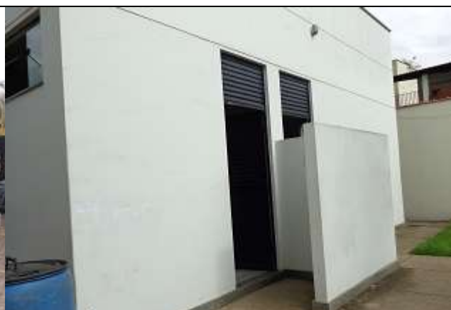
Foto 14 - Sanitários do posto
