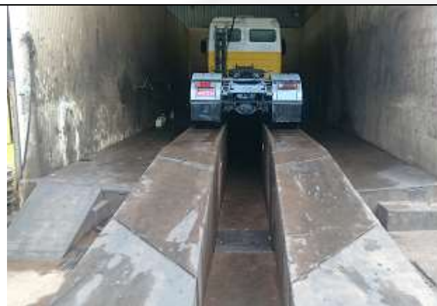
Foto 07 - Lavador de veículos
