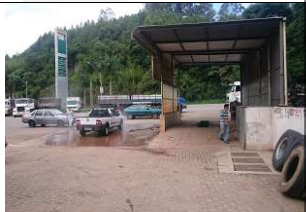
Foto 09 - Lavador de veículos
