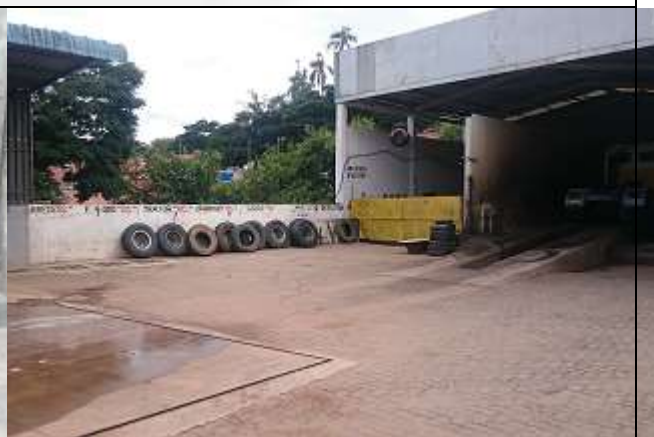
Foto 08 - Pátio e lavador de veículos
