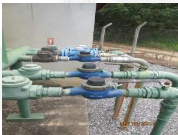
Figura 10. Pontos de captação com hidrômetros.
