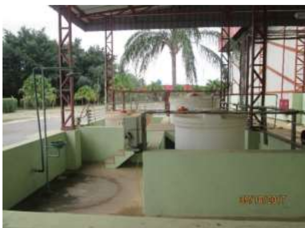
Figura 11. Bacias de contenção na central CIP.
