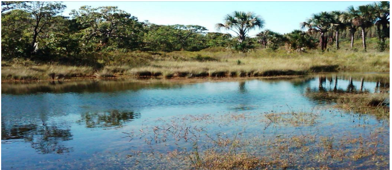
Figura 15 - Barramento existente no Ribeirão do Corrente
