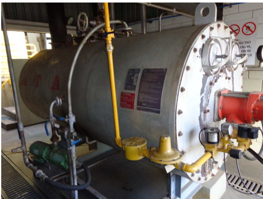
Foto 2: caldeira movida à Gás Liquefeito de Petróleo- GLP
