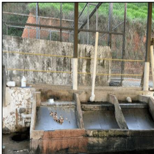
Figura 01: Estação de Tratamento de Efluentes: peneiras estáticas
