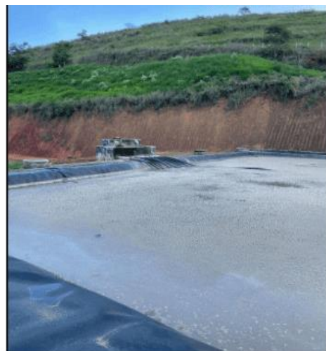
Figura 02: Estação de Tratamento de Efluentes Lagoa anaeróbia
