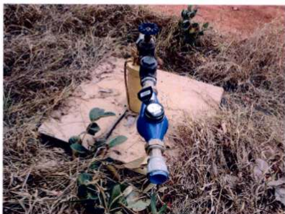
Instalação do hidrômetro
