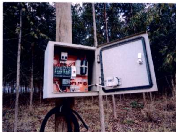
Instalação de horímetro
