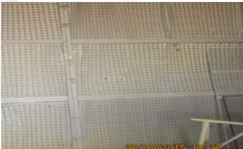
Figura 5: Filtro tipo cartão plissado com manta de polietileno.
