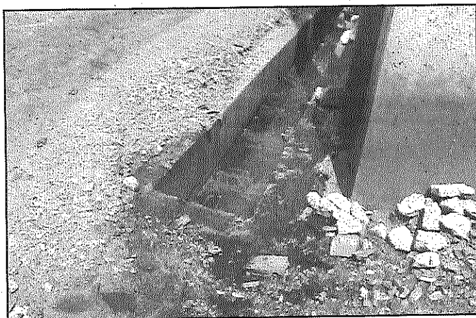
Foto 05: Canaleta de drenagem pluvial.
