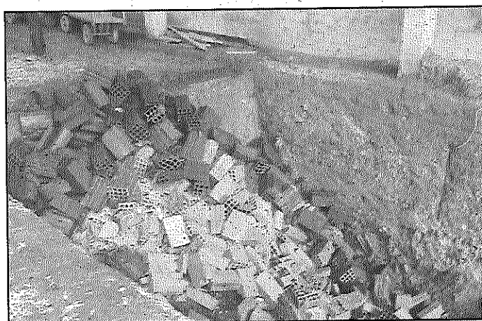
Foto 07: Tijolos quebrados (cacos) que retornam ao sistema produtivo.
