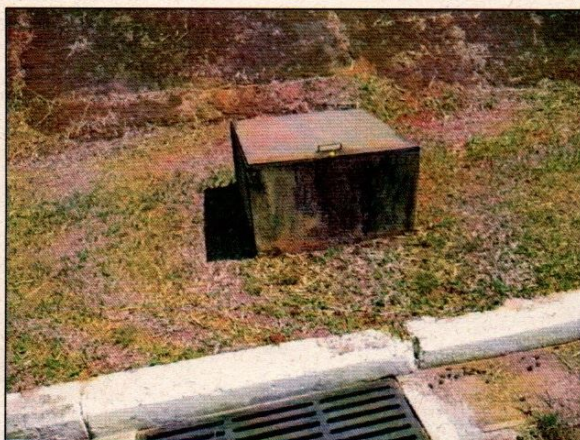
Figura 5: Exemplo de poço de monitoramento sem identificação.
