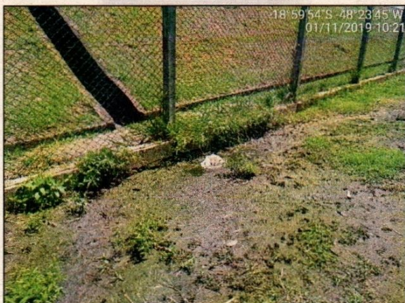
Figura 3: Extravasamento da vala de infiltração.
