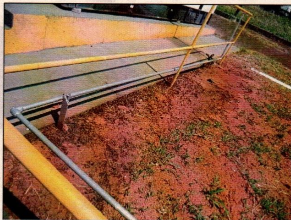
Figura 10: Vazamento de óleo diesel do gerador.
