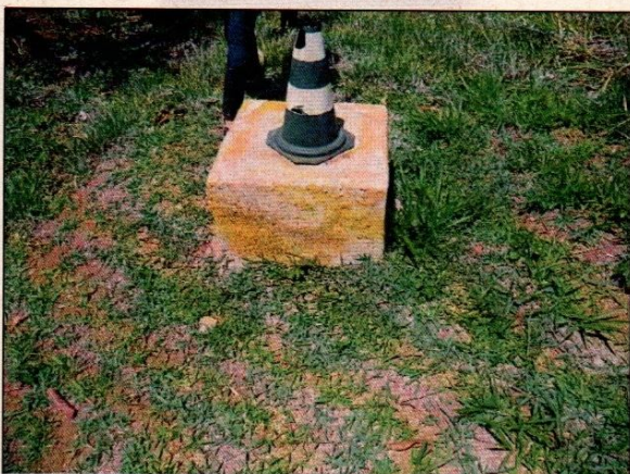
Figura 7: Exemplo de poço de monitoramento sem identificação.
