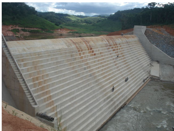
Foto 01. Barramento PCH Pipoca.
