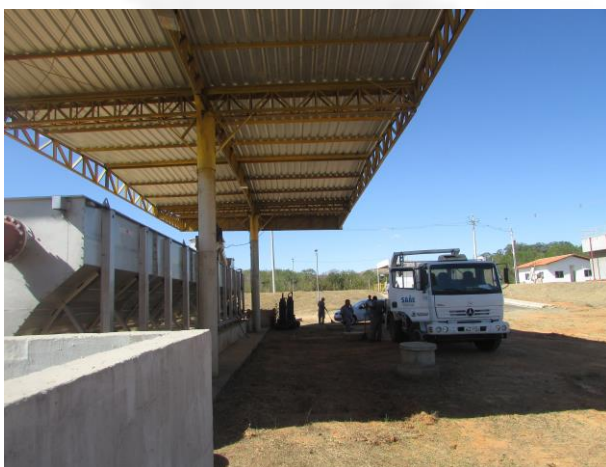
Foto 5: Pre-Tratamento da ETE Santos Dumont. Caixa medidora de vazão e Caixa desarenadora
