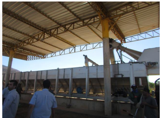
Foto 6: Pre-Tratamento da ETE Santos Dumont. Visão lateral da Caixa desarenadora
