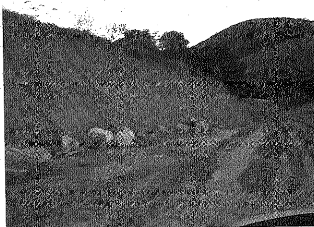
Foto 6: Estrada de transporte de minério/estéril.
