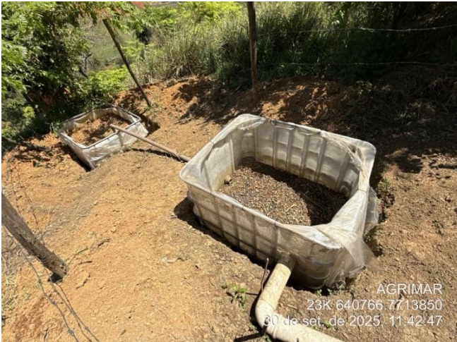
Foto 3. Filtro que retém óleo dos efluentes da lavagem da moagem.
