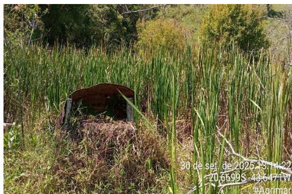
Foto 10. Cobertura vegetal de taboas ( Typha spp.) na APP próximo ao barramento
