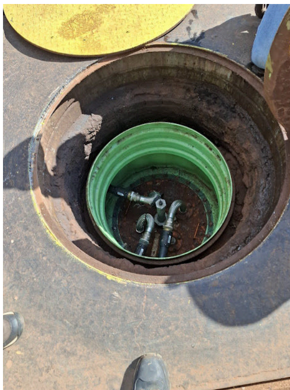
Boca de visita de tanque subterrâneo
