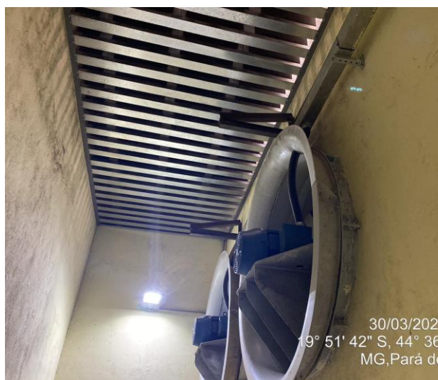
Foto 04. Supressor de ruídos da câmara climatizada – teto.
