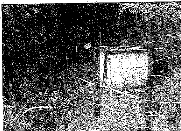
Foto 5. Paio para armazenamento de explosivos
