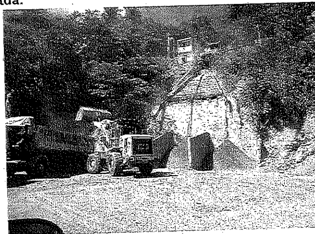
Foto 2. Área de carregamento de produto:
