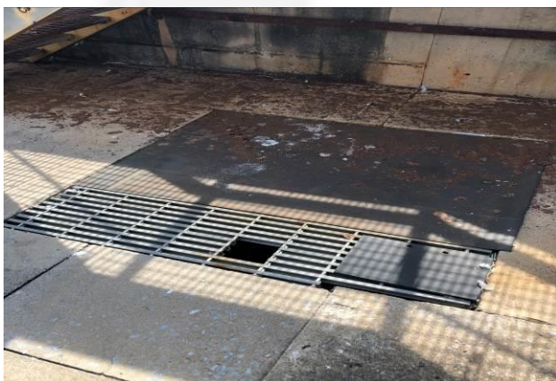
Grades Pultrudadas dos reatores anaeróbicos
