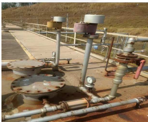
Corrosão na tubulação de coleta do Biogás
