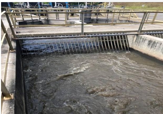
Gradeamento ( Tratamento Preliminar)
