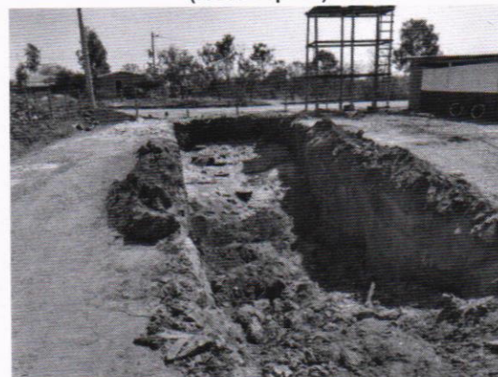
Foto 6: Usina de Asfalto em fase de instalação (balança)
