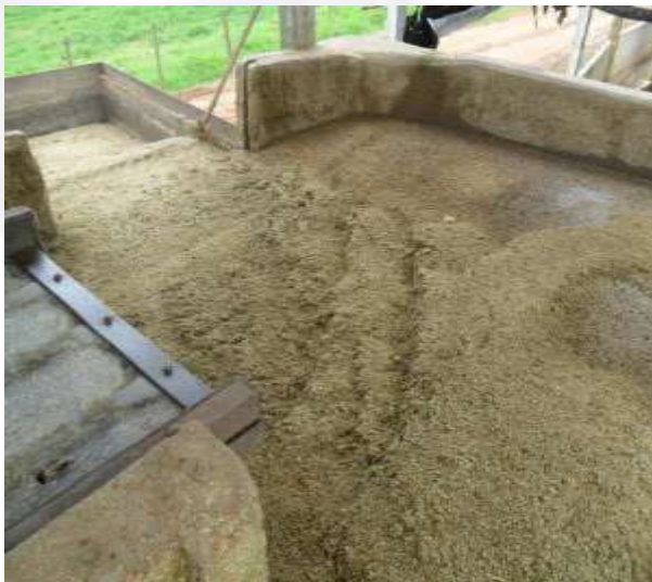
Figura 1: tanque de armazenamento
