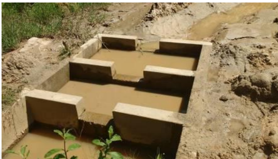
Figura 04: Sistema de decantação tricompartimentada.
