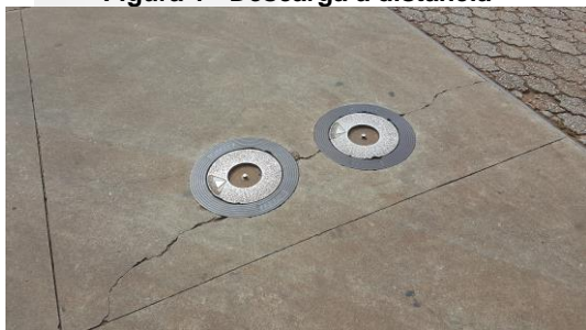
Figura 2 - Trinca na área dos tanques.
