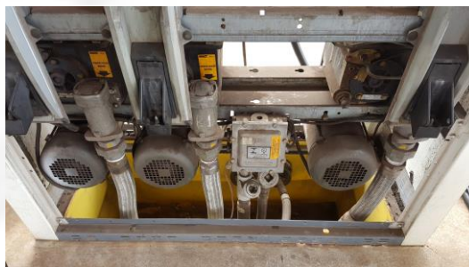
Figura 3 - Sump de Bomba e Check Valve
