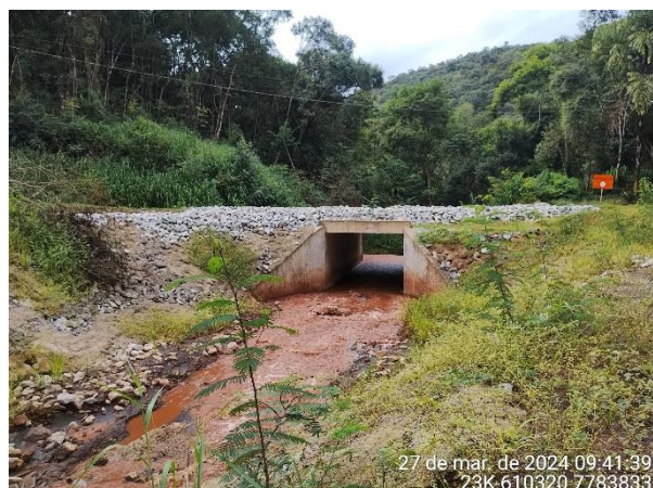
Foto 2: Implantação de galeria para passagem de água do córrego Taquara sob a Alameda do Seu João.
