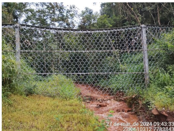
Foto 1: Barreira dinâmica implantada sobre o leito do córrego Taquara, próximo à Alameda Seu João.
