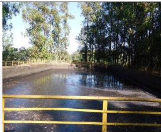
Foto 08. Tanque decantação de sólidos
