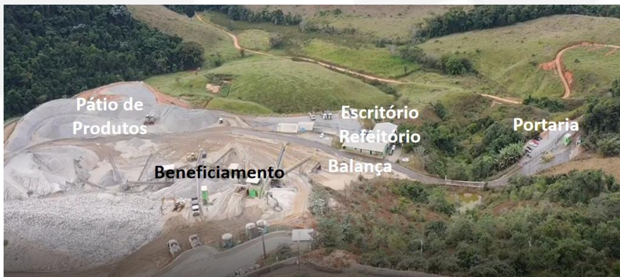
Figura 7 - Visão da área de apoio das operações da MED. Fonte: FEAM, 2025.
