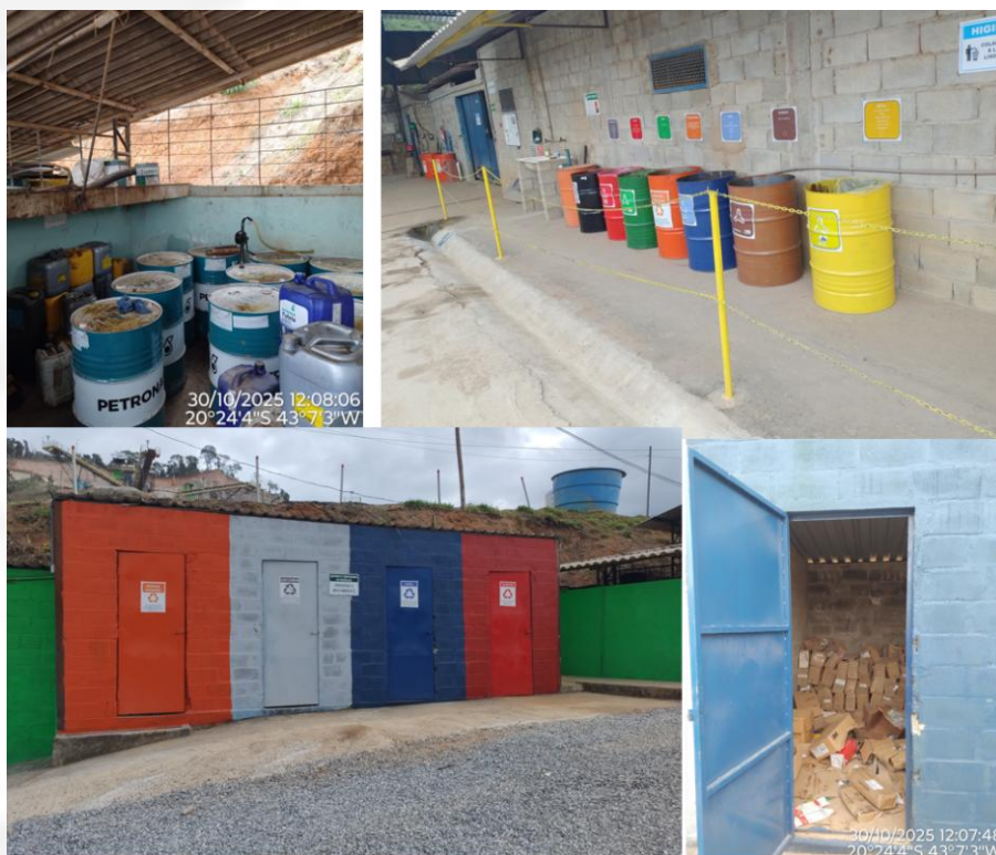
Figura 31 - Ilustração do Depósito Temporário de Resíduos e estruturas de recolhimento, segregação e acondicionamento existentes no empreendimento. Fonte: FEAM, 2025.
