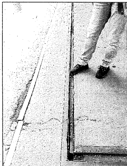
Foto 5: Canaletas de drenagem
