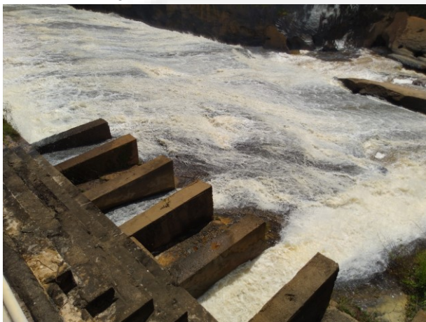
Foto 03 – Descarregadores de fundo da barragem.
