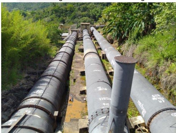
Foto 05 – Início dos condutos forçados (CHG).
